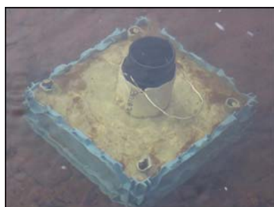
Figure 4. Sédibloc reposant sur le lit de la rivière Cachée.
